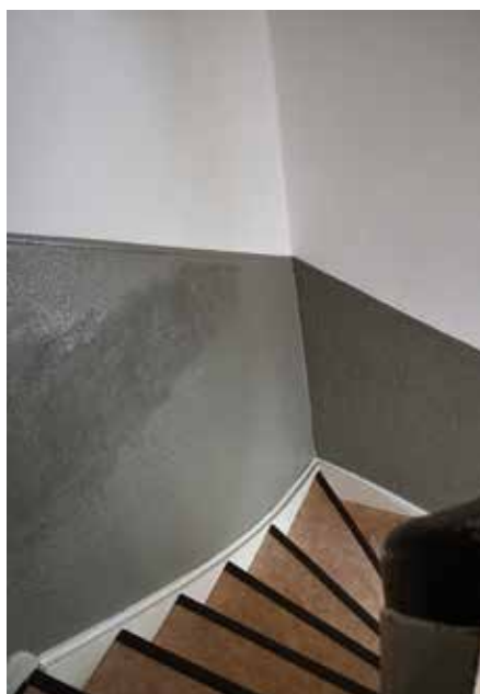
Der in Eigenleistung renovierte Flur
