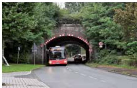
Nadelöhr: Bahnbrücke unterhalb der Kreinberg-Siedlung
